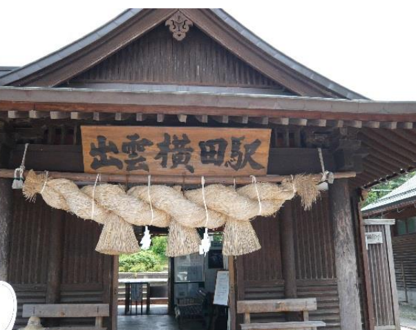
大しめ縄が張られた宮造りの出雲横田駅舎
